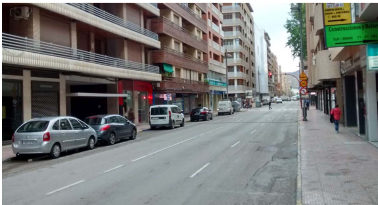
Figura 102: Relación acera / calzada desproporcionada en la Avda. Juan Carlos I
