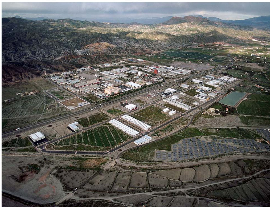
Figura 71: Vista aérea al Polígono Industrial Saprelorca
