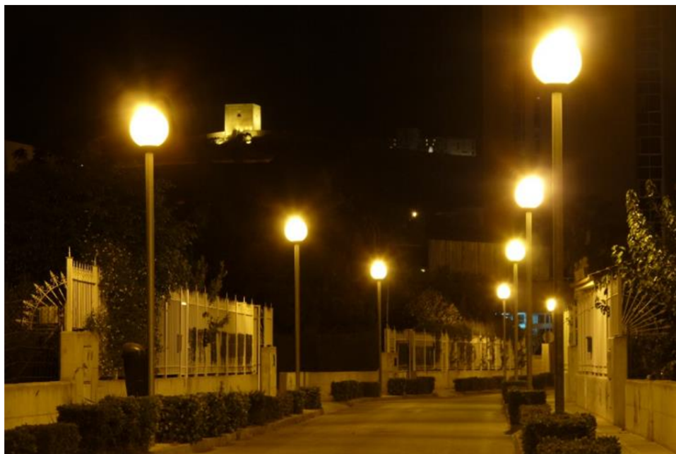
Figura 119: Farolas con contaminación lumínica junto a las alamedas y Torre Alfonsina al fondo
