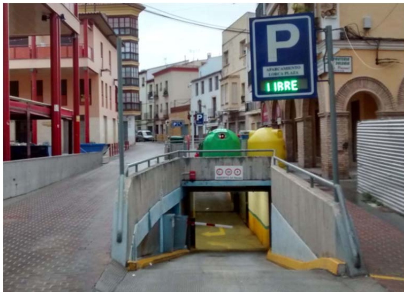
Figura6: Boca de entrada al parking que rompe la imagen de la calle
