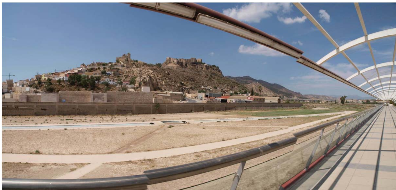
Figura 110: Pérgola en la pasarela junto al río Guadalentín
